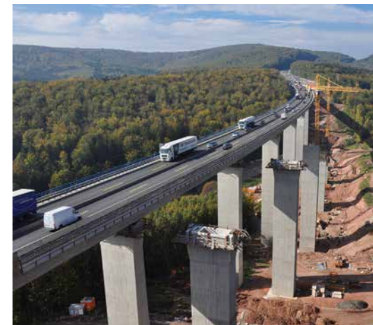
Haseltalbrücke bei Rohrbrunn/Marktheidenfeld
